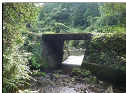
橋長 5m 未満の橋梁
