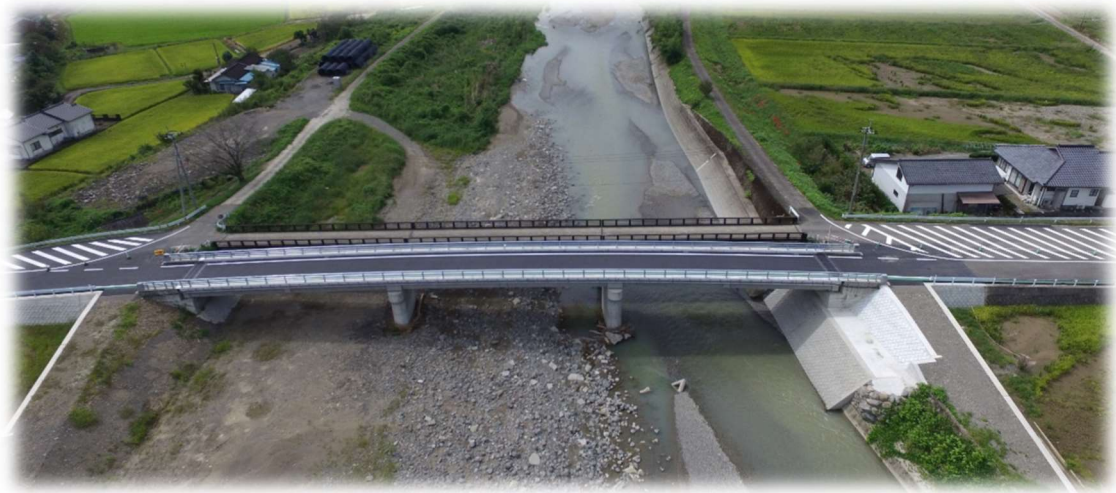
村道県道下段線「下之段橋」R2.5 架設
