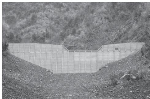
谷止工は、背面に土砂を堆積させることで溪流の浸食や山腹崩壊を防止するとともに、下流への土砂流出量を抑制することを目的としています。
