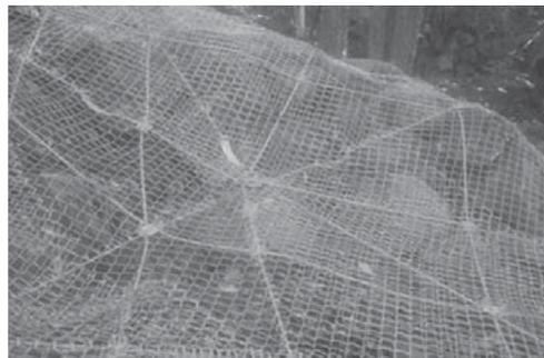
山腹工は、荒廃した山の斜面の崩壊や浸食を防いだり、植生を形成させることで、防災機能の高い森林に導くことを目的としています。
