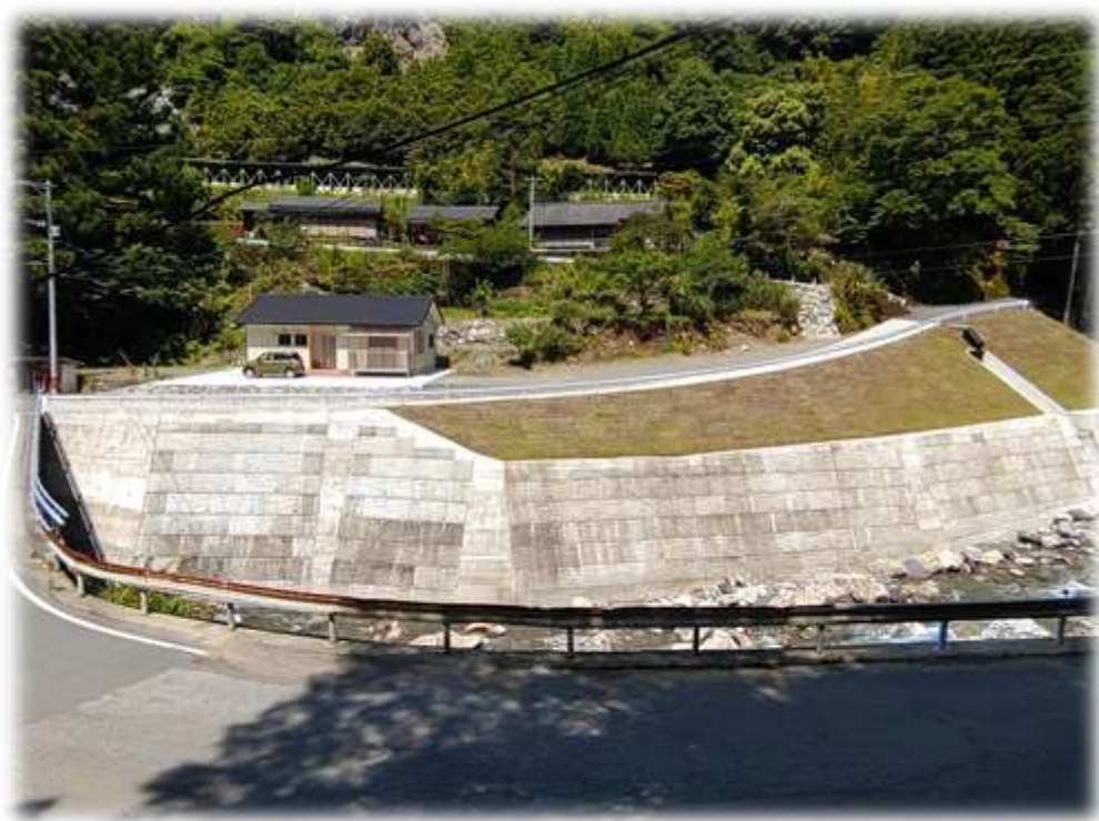
【村道大川内橋上部落線】
