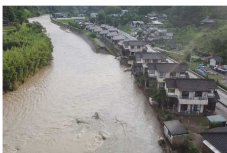
【護岸流失】万江城内地区
