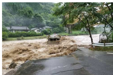
【橋梁流失】万江足算瀬地区
