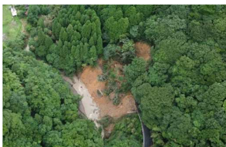
【道路決壊】山田下払地区
