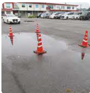
降雨後の役場前駐車場
