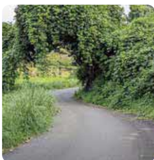
村道沿線の繁茂状況
