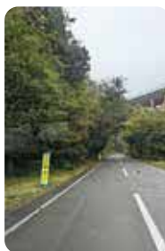
危険な支障木が繁茂する県道坂本人吉線
