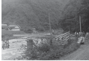
昭和の柚木川内橋 昭和38年架設中
