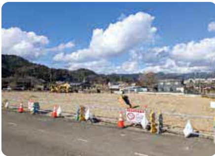
造成工事中の栗の駅建設地
