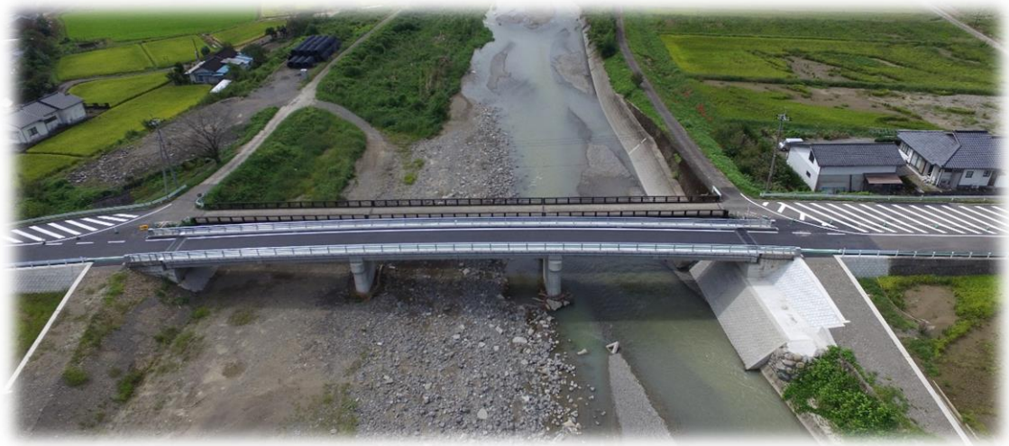
村道県道下段線「下之段橋」R2.5 架設
