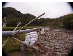
寸断された農地への用 水管(生業インフラ)
