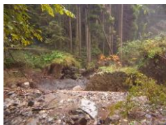
くずれた砂防堰堤 (生態インフラ)
