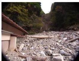
砂防堰堤を越してきた土砂
