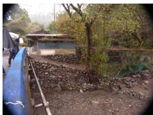
手作業で石の積み直しが されている
