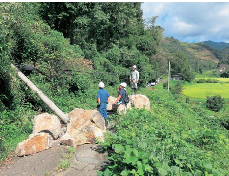
(災害発生時の西川内下払線)
