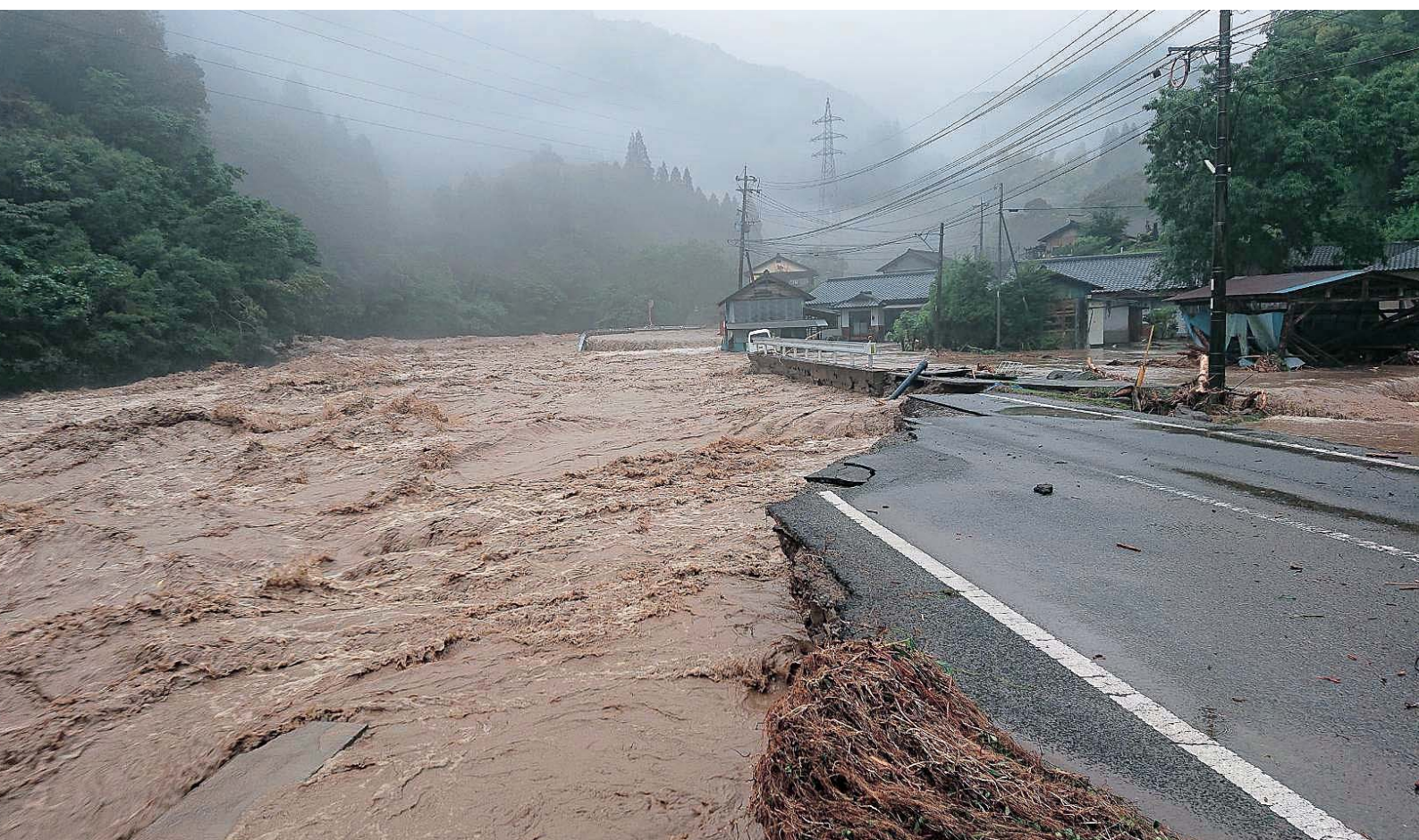
▲淡島地区で河川が氾濫。濁流は民家を襲い、川砂利と泥が宅内に入り込んだ。また、万江川の洪水により県道坂本人吉線も崩れ落ち、道路が寸断。車両での避難が不可能となり、付近の住民は高台に避難した
