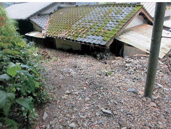
▲大雨による土石流が発生し山沿いの家屋にも土砂が流れ込んだ
