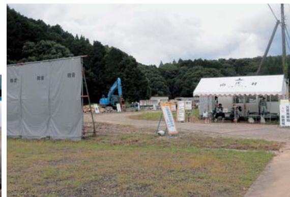
▲7月6日に萩野工業団地の一角に設置された災害廃棄物置き場 9区のふれあいパークみのばるは、球磨村の災害廃棄物置き場として開放された(写真:山江村の災害廃棄物置き場として設置された萩野工業団地)
