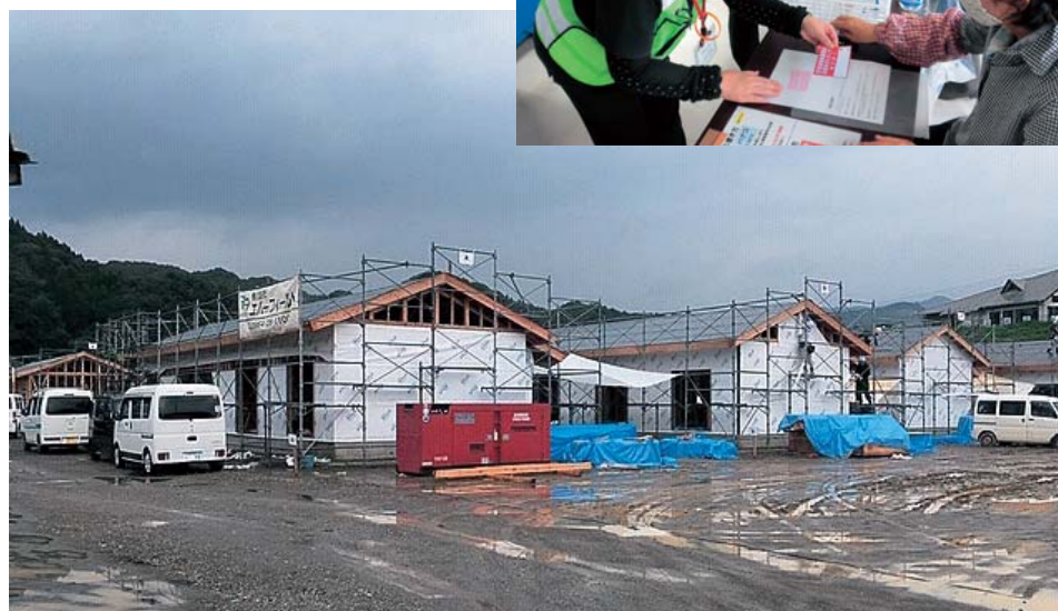
▲7月10日 熊本県が人吉市に15戸、山江村に25戸の仮設住宅建設を発表 翌日には建設工事を着工した 本村の仮設住宅は、中央グラウンドに建設される
