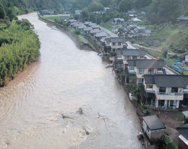
▲万江川増水により河川堤防が削られ、公営住宅の基礎が露わになり、家屋の一部が浮いた状態に。住宅の住民は安全な場所へ避難した
