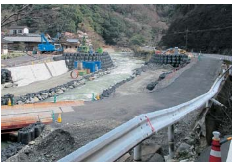
場所:村道県道柚木川内線(柚木川内橋)(万江地区)
