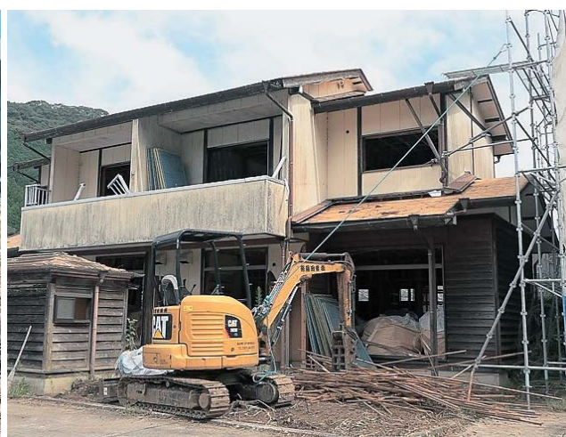
被災した城内団地の解体(9月)
