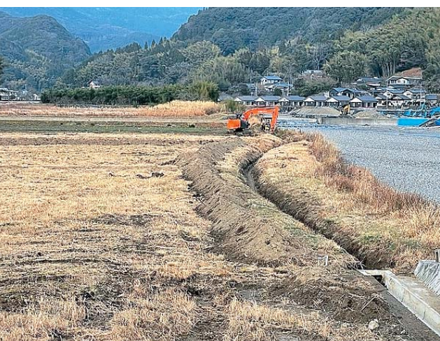
万江榎木町と熊山鶴の農地復旧工事が始まる(11月)
