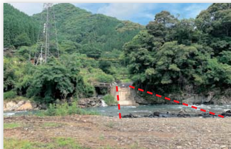
施工中(橋撤去)
