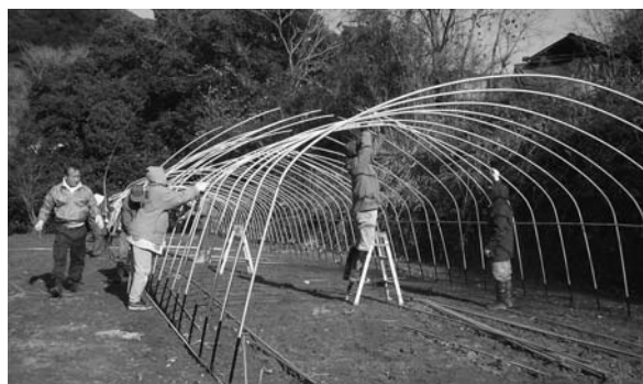
ビニールハウス製作中
