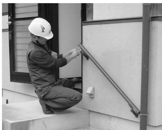
補修作業の様子
