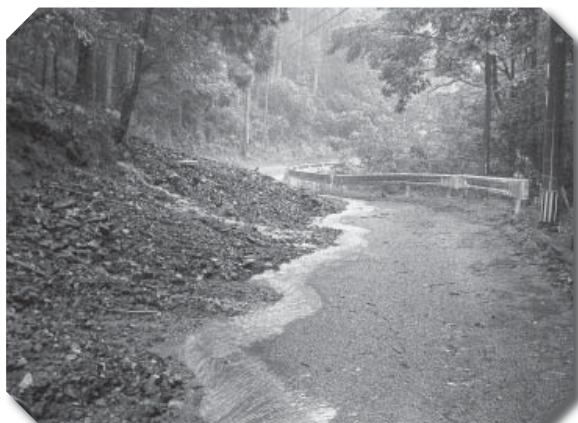
崩土 平成22年6月29日発生 山田尾寄崎
