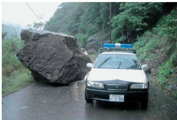
(大雨で道路に巨大落石 = 万江水無の村道)
