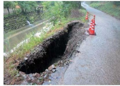
地盤が緩み陥没した道路(葛)
