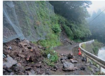
落石防止ネットも破壊された(合子俣)
