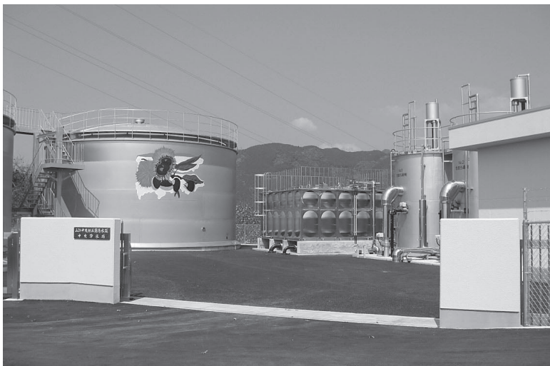
中央浄水場(全景)
