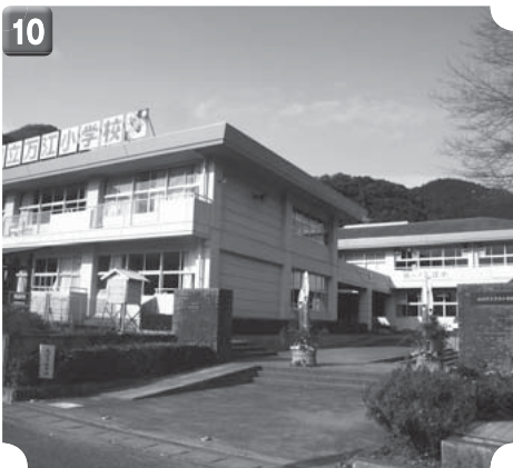
10 万江小学校校舎改修工事
