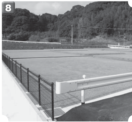
8 井出の口住宅団地造成工事完成
