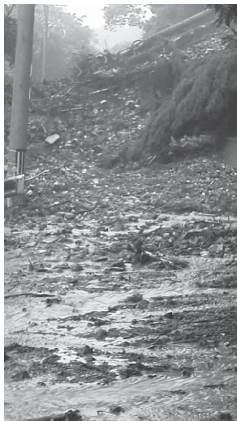
平成 24 年 7 月 12 日発生 崩土により通行止めとなった生活道路
