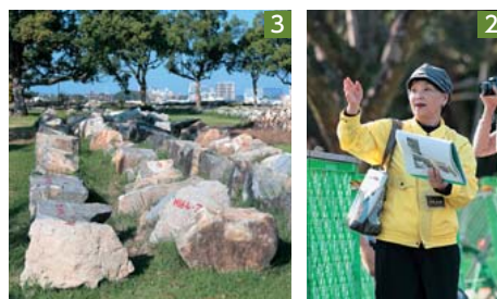
1_複数箇所石垣が損壊(写真は戌亥櫓) 2_修復中の熊本城を案内するボランティアガイド 3_同じ位置に復元するため整理された崩れた石垣
