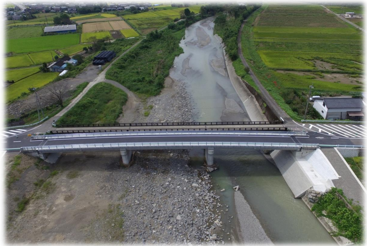
【道路メンテナンス事業:村道県道下段線(下之段橋)】
