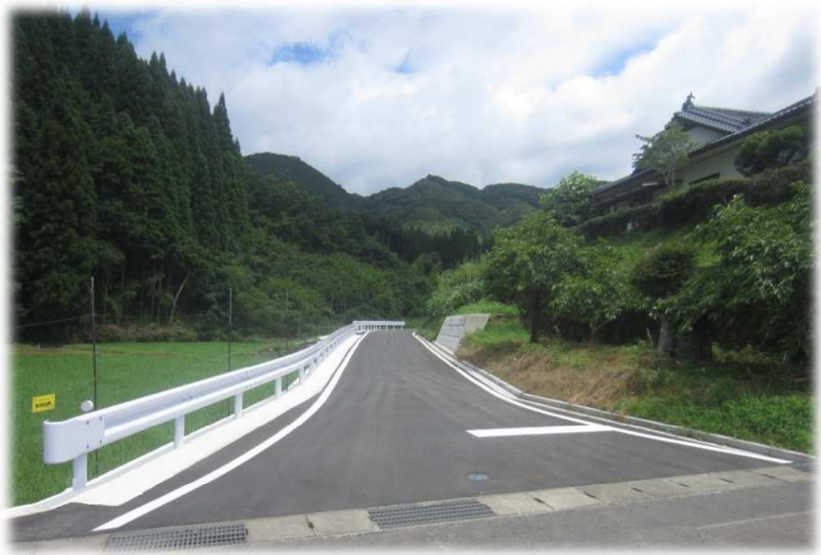
【村道古敷金ノ平線道路改良工事】
