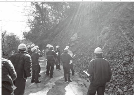
林道屋形線1号箇所災害復旧工事
