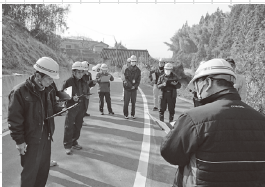
村道古敷金ノ平線道路改良工事
