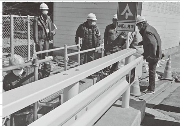
村道吐合宇那川線(吐合橋) 橋梁補修工事
