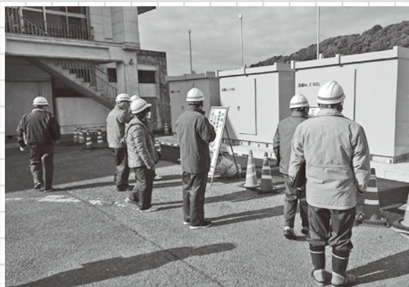
役場庁舎非常用電源設備整備工事
