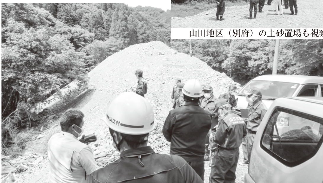
河川沿いに設けてある仮土砂置場
