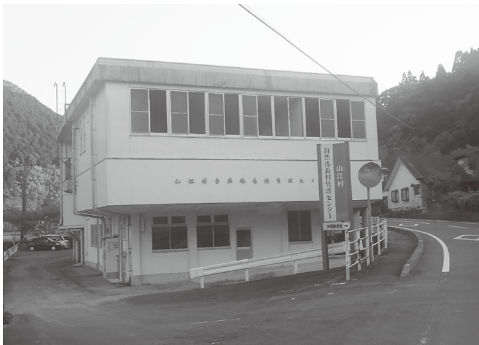
補修・改築が必要な管理センター
