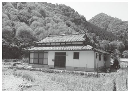
被害を免れた淡島ゲストハウス
