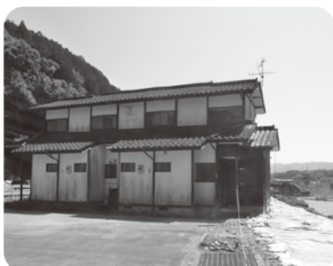
全壊判定を受けた城内団地
