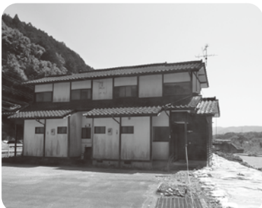
全壊判定を受けた城内団地
