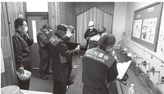
山江村小中学校水栓自動化改修工事
