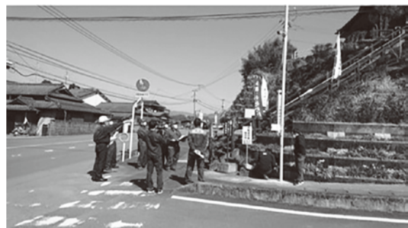
防犯カメラ設置工事
