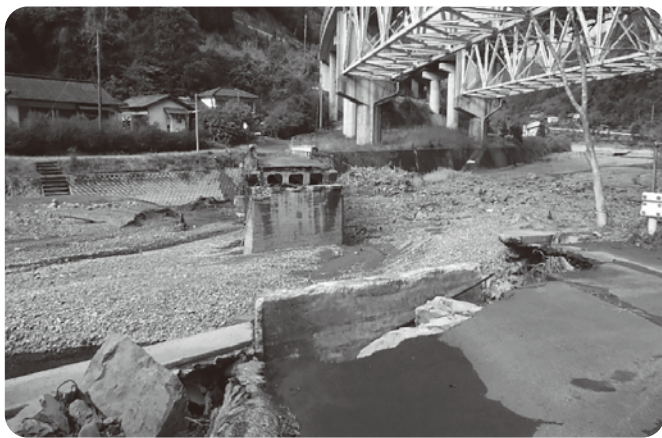
橋梁災害 万江足算瀬地区
