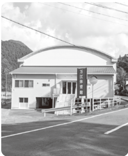
今回改修された万江体育館
