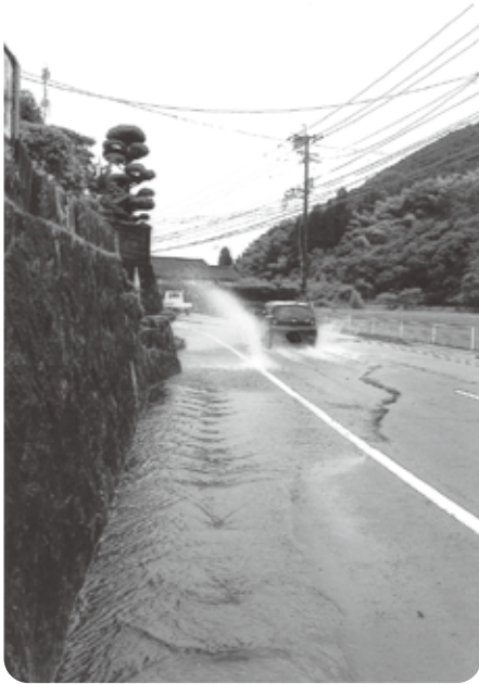
大雨後の県道 17 号線
