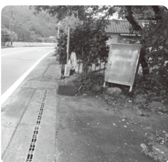
万江地区の消火栓
