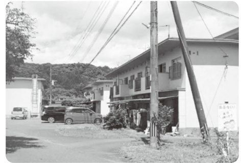
建て替え工事予定の林田団地
