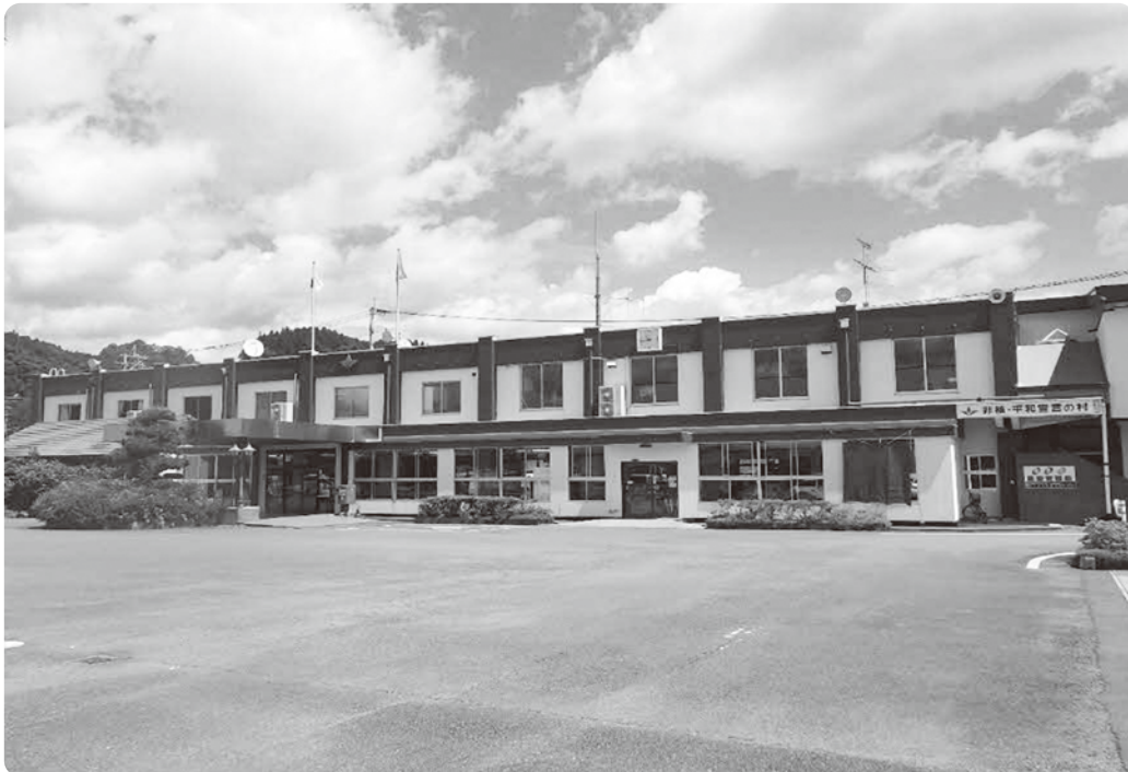
建て替え時期がきている庁舎（築49年）
