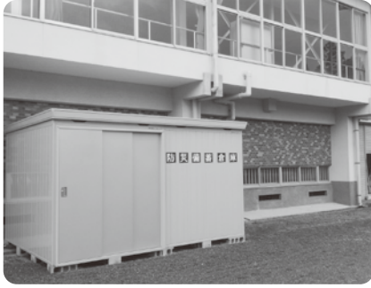
山田小学校の備蓄倉庫
