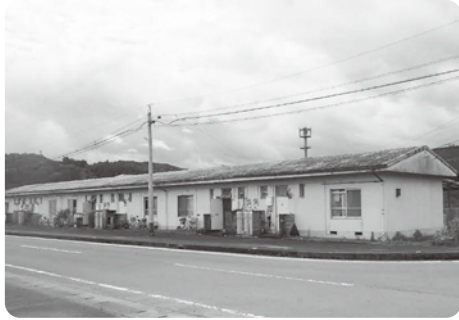
改修工事予定の寺の下団地
