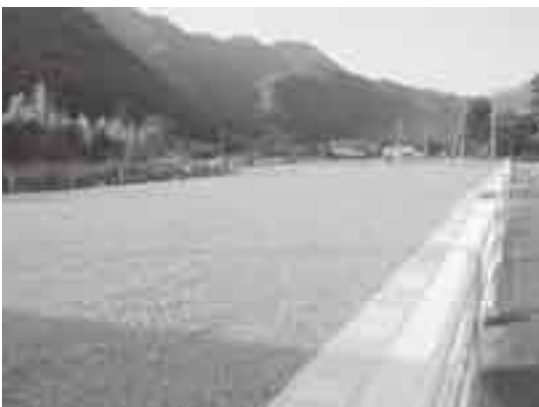
造成を終えた建設予定地
