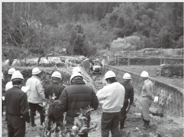
淡島谷川の災害復旧現場
