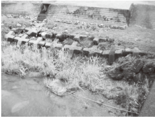
護岸が洗掘された山田川（合戦の峰）
