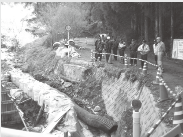
西小路橋架替工事
