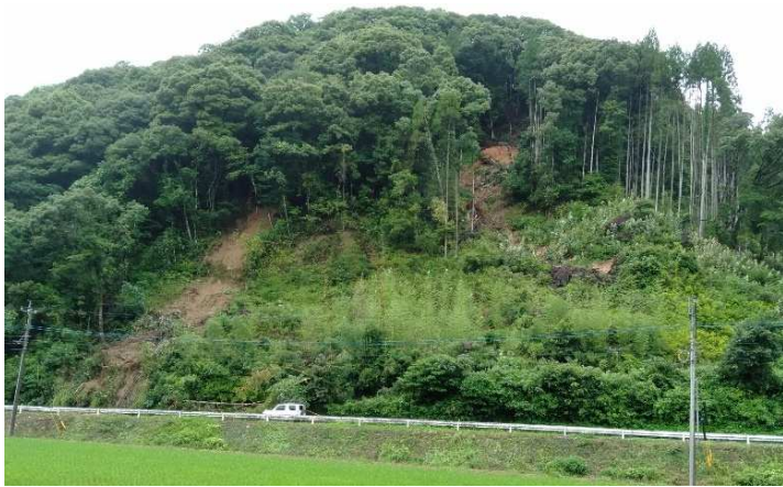
【山腹崩壊】湯の原地区
