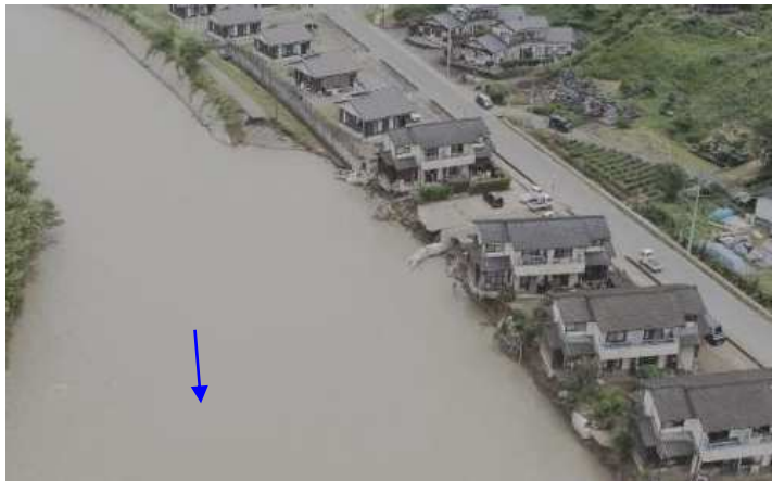
【護岸決壊】城内地区
