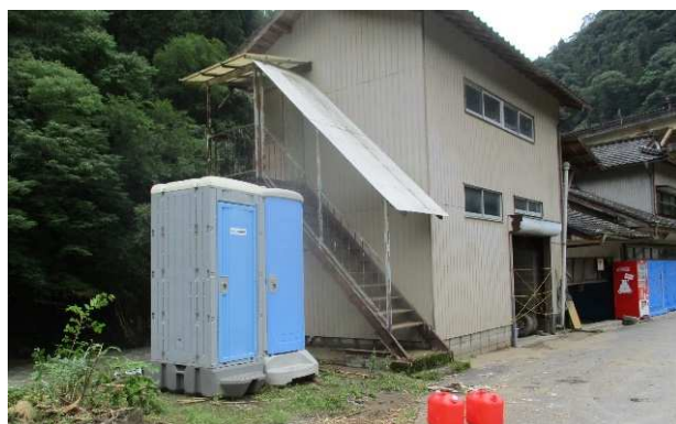
応急仮設トイレ（葛地区）
