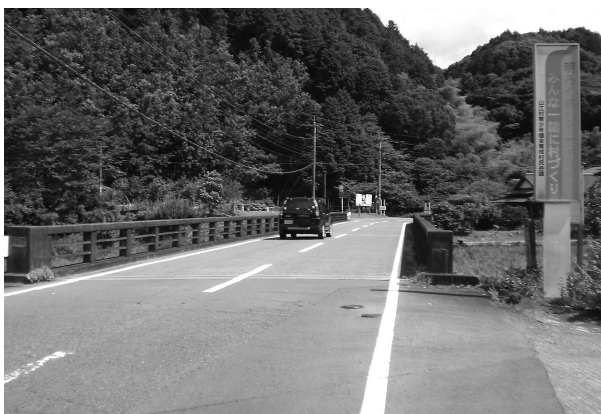
県道17号 神園橋
