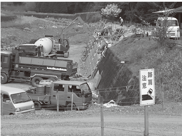
災害復旧工事
