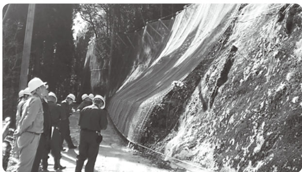
村道宇那川戸屋線防災工事
