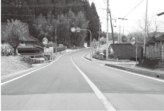
計画的に進められている村道舗装補修工事
