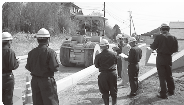
村道日向瀬小山田線道路改良工事
