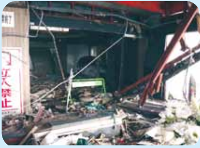
被災した陸前高田市役所 庁舎の中に車が流れ込んでいます
