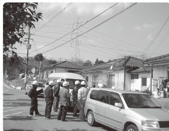
北永シ切団地建物分棟工事
