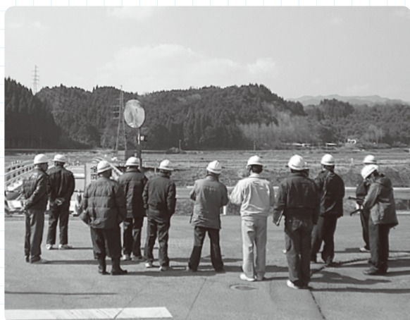
村道合戦の峰白鳥線橋梁補修工事
