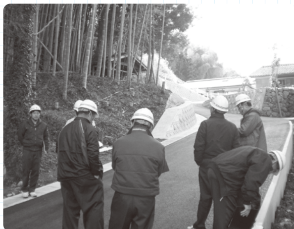
村道城内神園線道路新設工事
