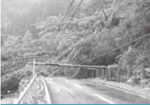
山腹崩落により県道塞ぐ（白岳地区）
