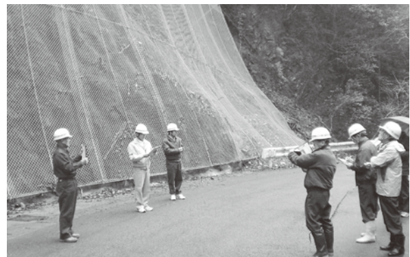
村道吐合宇那川線防災工事(H26)
