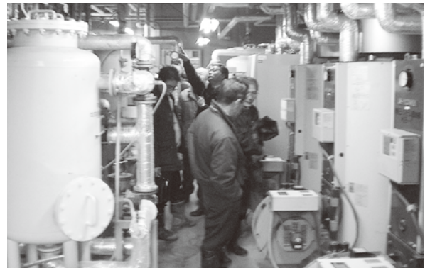
山江温泉ほたる機械改修工事(H26)
