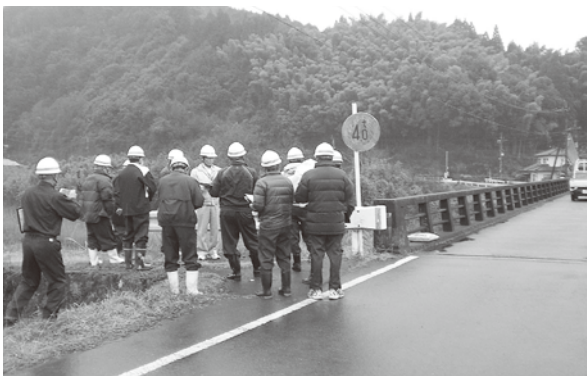
村道県道下ノ段線橋梁取付道路工事(H27予定)
