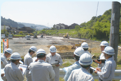
公営住宅建設に伴う造成工事(西川内地区)
