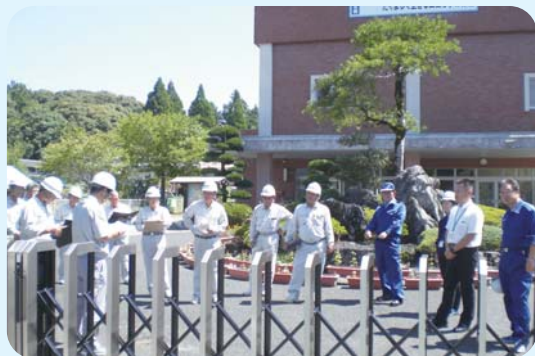
山田小学校門扉取替工事
