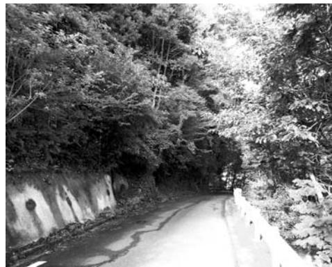
改良が進まない村道神園平山線
