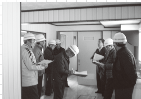
空き家改修工事（淡島地区）
