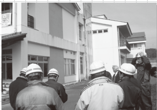
山江中学校校舎外壁塗装工事（H29年度予定）
