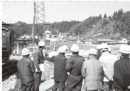
村道県道下段線橋梁架換工事（下ノ段地区）
