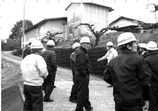
道路破損状況確認（合戦峰本城地区）
