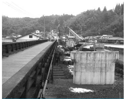
急ピッチで橋梁工事が進む下ノ段橋
