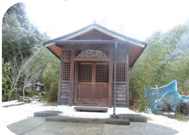
④大川内薬師堂(大川内)
