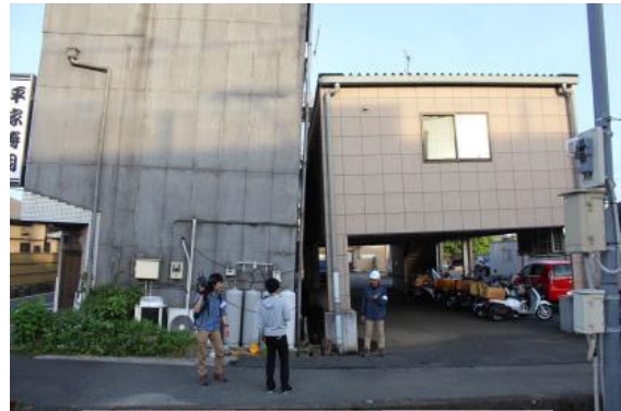
写真 3-2 液状化による建築物の傾斜
