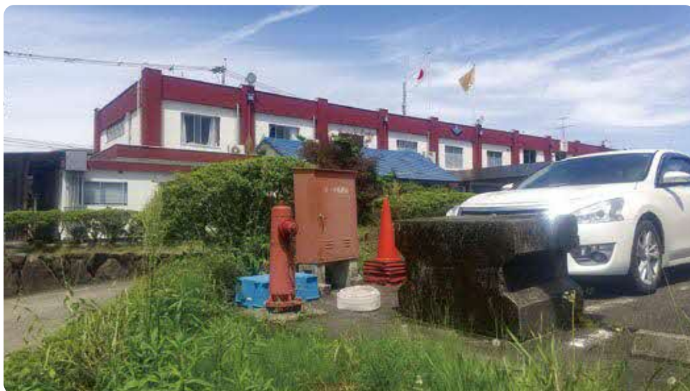
林田団地の消火栓は役場敷地内
